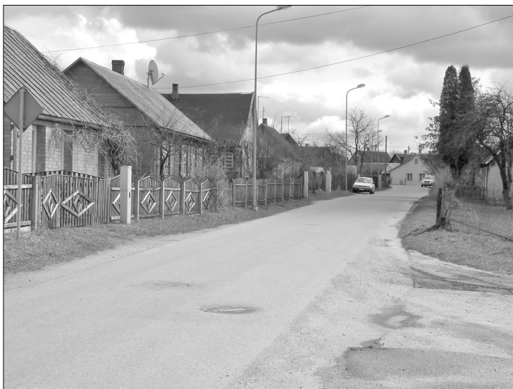
Ziedu ielas iedzīvotājiem būs iespējams pieslēgties centrālajai ūdensapgādei un kanalizācijai
