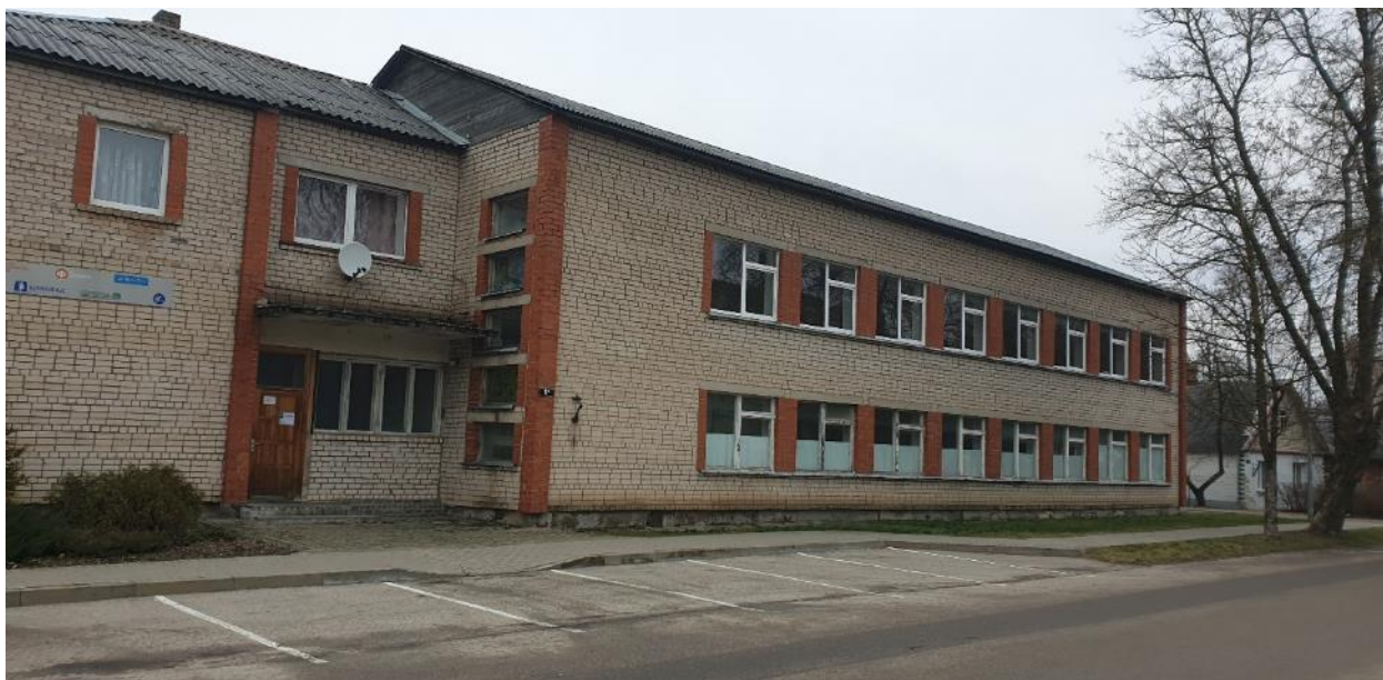
5.attēls. Skats uz lokāplānojuma teritoriju no lokāplānojuma teritorijas dienvidu puses jeb A.Paulāna ielas.
